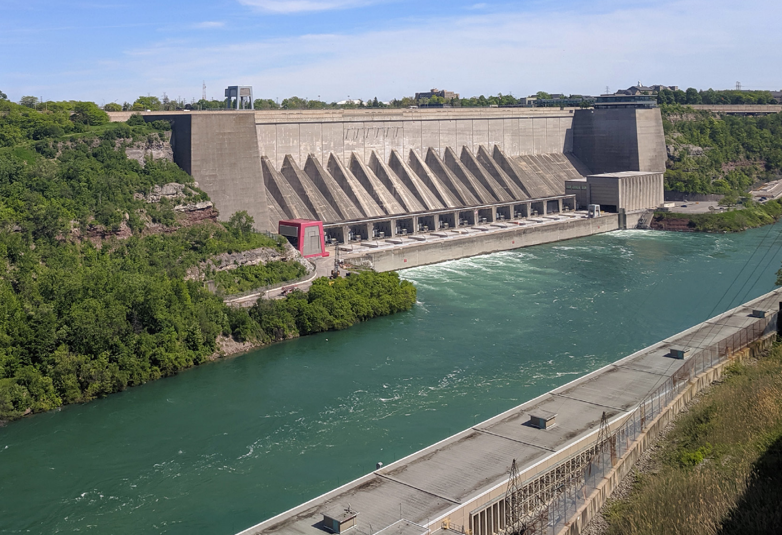
Das am Niagara-Fluss im Staat New York gelegene Wasserkraftwerk Robert Moses wird modernisiert.
